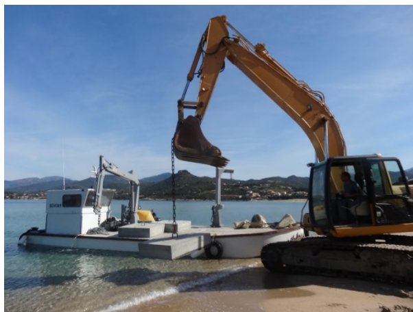
Figure 12 : Chargement des corps-morts sur la barge
